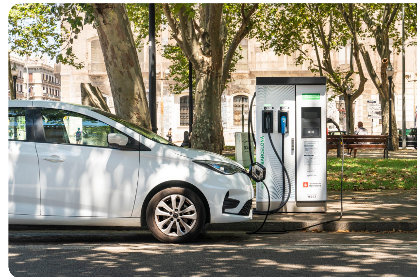
Punt de recàrrega elèctrica Endolla, imatge d'arxiu.
